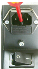
FIGURA 14: SOSTITUZIONE DEL FUSIBILE PRINCIPALE
